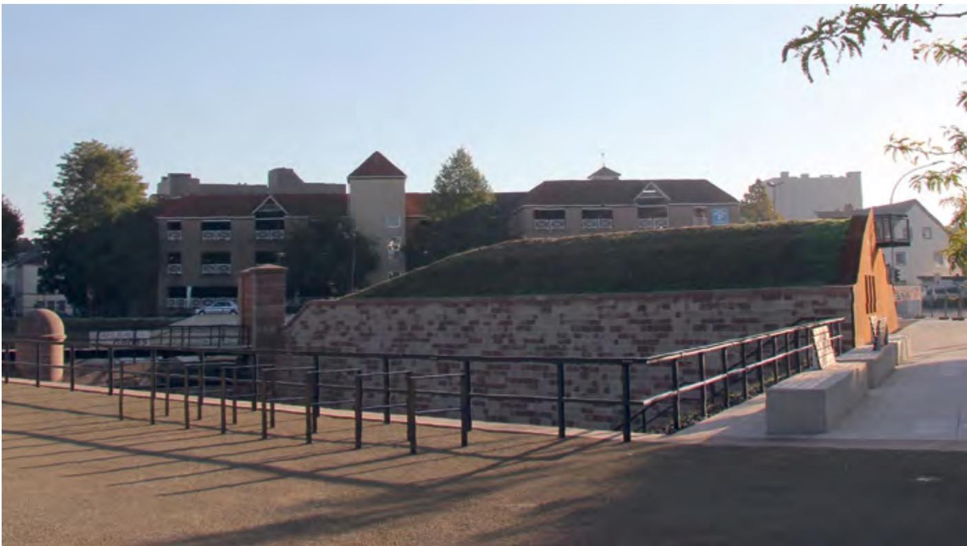
Die rostrote Cortenstahl-Platte ist nicht nur ein dekorativer Abschluss für die Ravelin-Schulter, die im 4. Bauabschnitt wieder aufgebaut wurde, sie stellt vor allem den sichtbaren Schnitt zwischen historischer und moderner Stadt dar. Daneben verläuft der Ravelin-Graben bis zum Batardeau.
